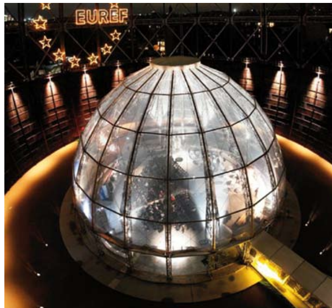
Gasometerkuppel bei Nacht Quelle: EUREF
